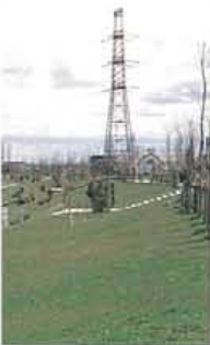
自然型護岸工法(茨戸川)
