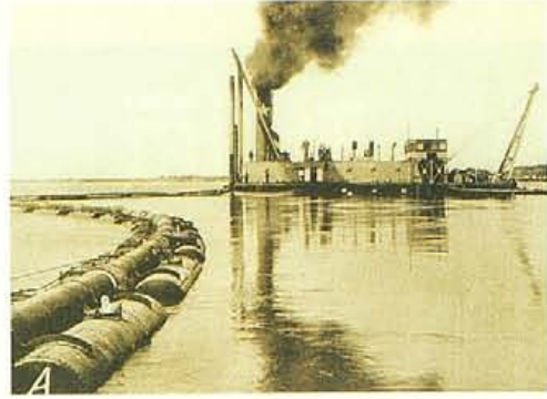
ポンプ浚渫船 昭和号
