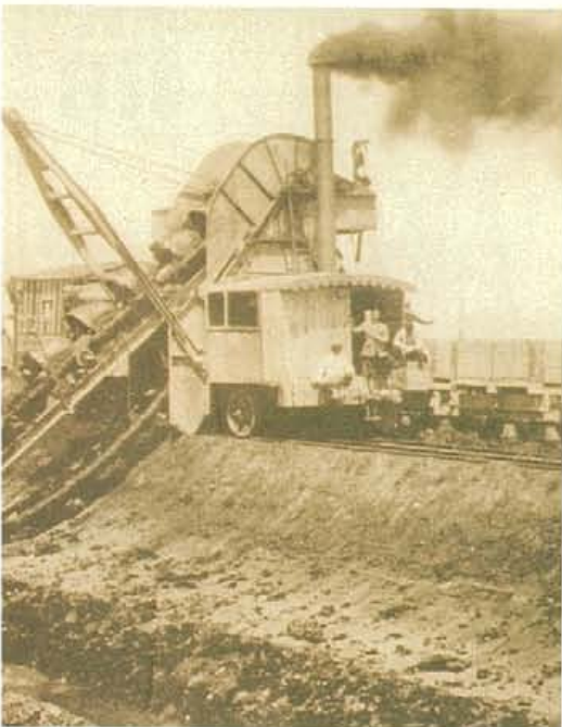
新水路工事中の掘削機(エキスカ)
