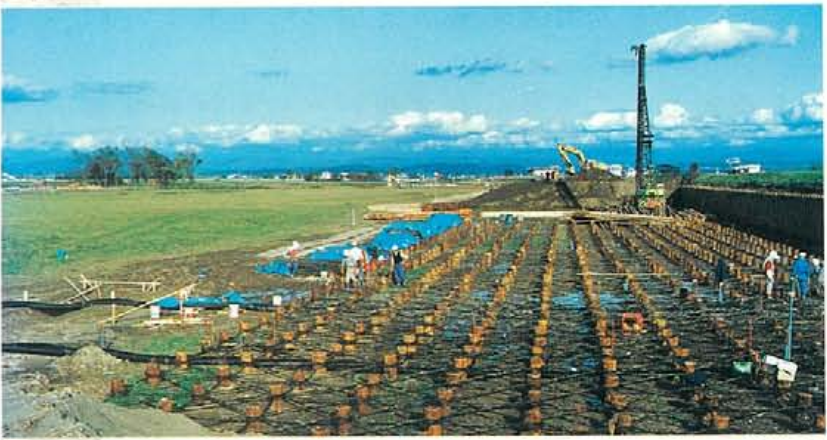
軟弱地盤対策工法(石狩川下流)
