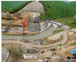
建設中の滝里ダム(空知川)
