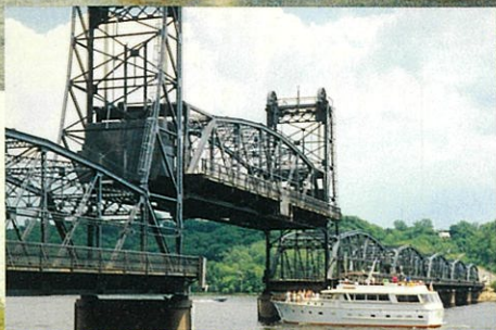
船舶航行のため、橋にも配慮している。
