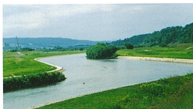
低水路護岸と河畔林 剣淵川(士別市)
