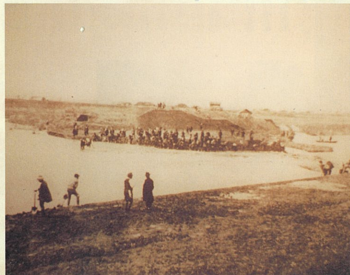
▲夕張川新水路通水 昭和11年5月
