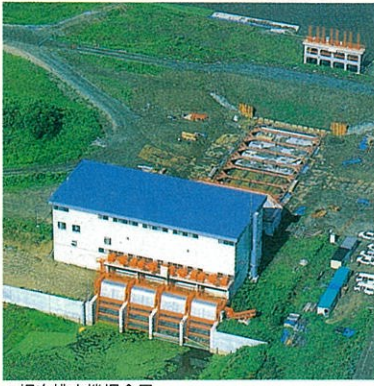
▲南向排水機場全景
