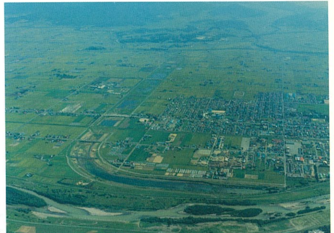
▲工事中の牛朱別川分水路全景
