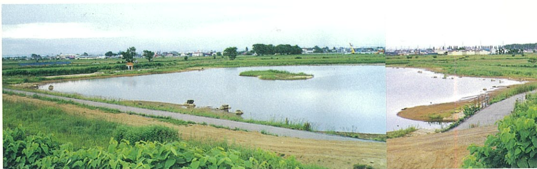
▲多目的利用施設整備が進む遊水地(東側)
