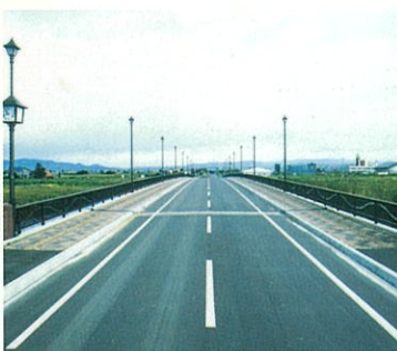
▲橋梁工事(第一北永橋)
