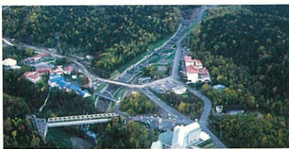
▲尻無沢川流路工完成写真
