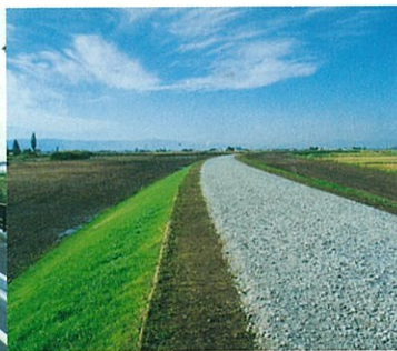
▲築堤工事(左岸上流)
