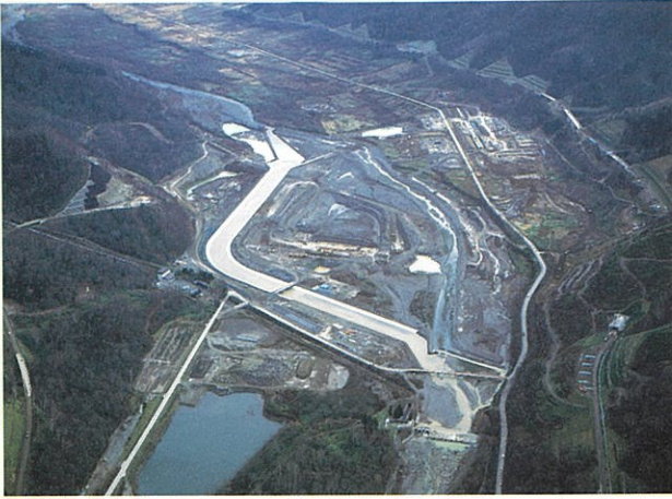
▲平成6年11月に完了した一次転流(写真中央の水路)
