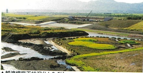
▲越流堤施工状況(H.6.秋)
