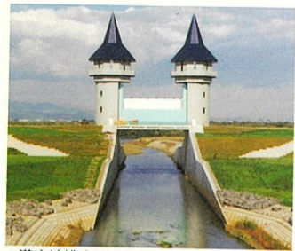
▲遊水地排水門
