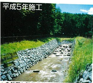
▲自然石と階段落差工
