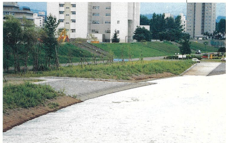
▲消火用水取水用護岸 金星橋下流左岸
