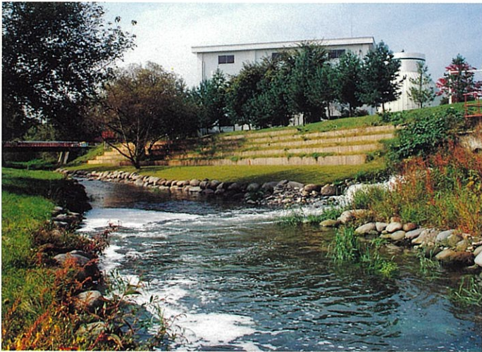
▲旧帯広川環境整備事業（帯広市施工）
