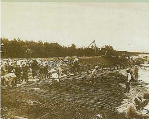
石狩川における沈床の組立例
