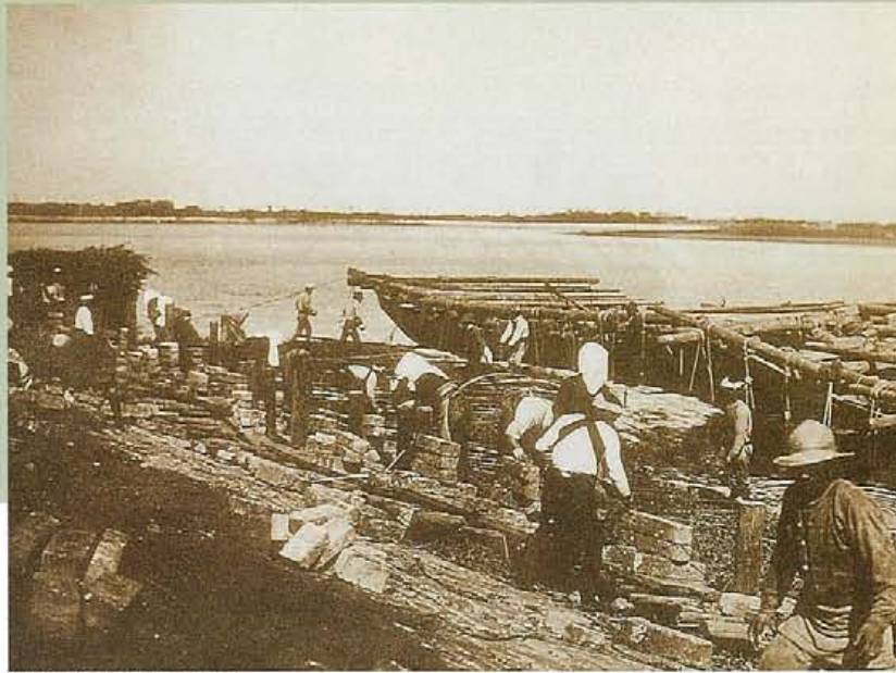
石狩川における沈床の組立例
