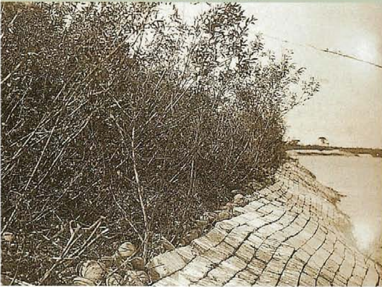
石狩川鉄筋混土単床及び柳枝工護岸工事 (大正初) 石狩川岸花畔付近
