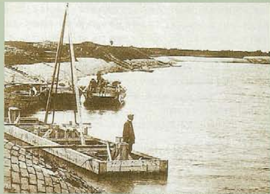
生瀬新水路ブロック単床布設全景-洗掘されて立つブロック
