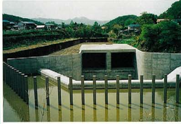
パンケ歌志内川 河川トンネル呑口 (工事中)
