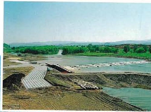
石狩川改修工事の内 永山床止工事
