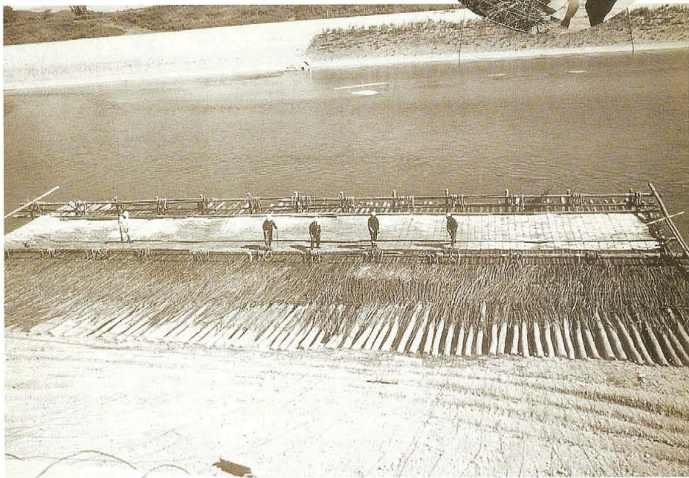
大水深河岸における台構工法による連結護岸施工例
