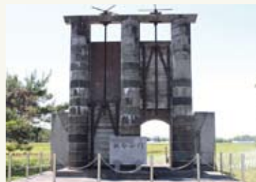
1980年代後半まで使われていた手動式のユニークな調節水門（写真提供：深川市）
