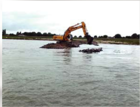
ワール川の水制工切り下げ工事
