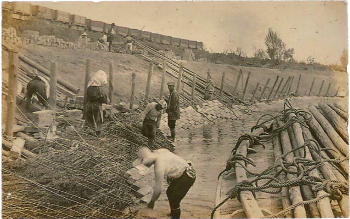
平成 27 年度選奨土木遺産 茨戸川の岡崎式単床ブロック護岸。当時の施工風景（竣工大正 6 年）。国内に普及している連節護岸の礎となる施設。
