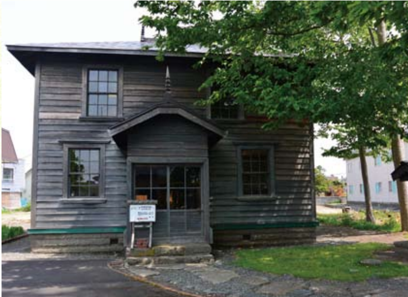
伊達邸別館（明治 13 年建築、迎賓館。当別町有形文化財）当別町元町 105 番地 1
