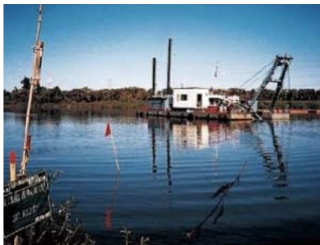
茨戸川での浚渫作業状況
