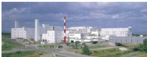
西部スラッジセンター下水汚泥の高度処理施設
