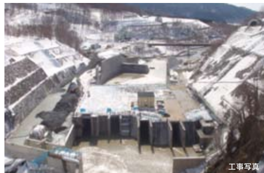
工事写真 2009年4月
