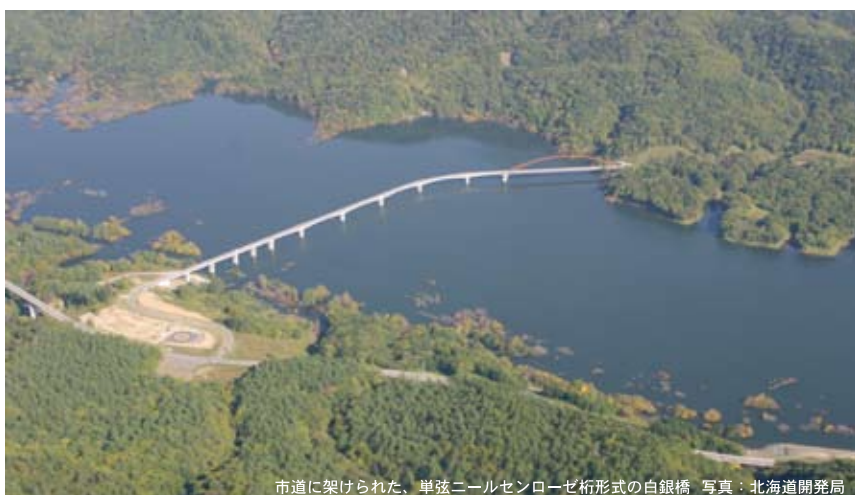
市道に架けられた、単弦ニールセンローゼ桁形式の白銀橋 写真:北海道開発局
