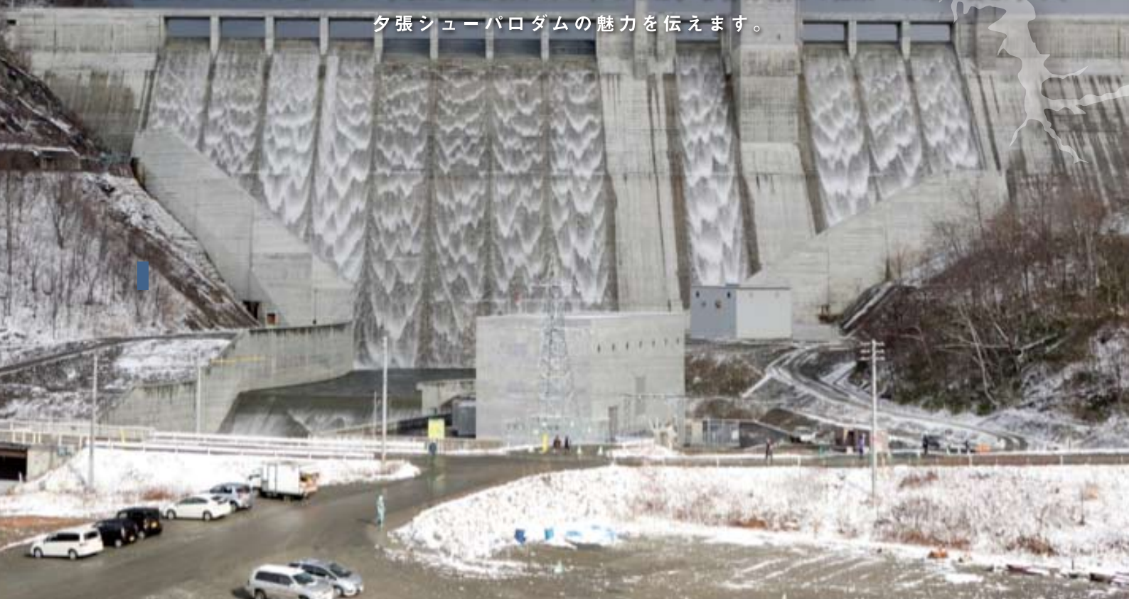
試験湛水におけるダムからの越流状況 人や車との対比を見ても、夕張シューパロダムの壮さに圧倒される 写真：石狩川振興財団
