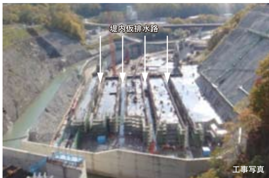
工事写真 2008年11月
