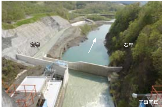
工事写真 2005年10月
