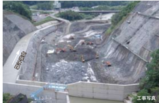
工事写真 2007年8月
