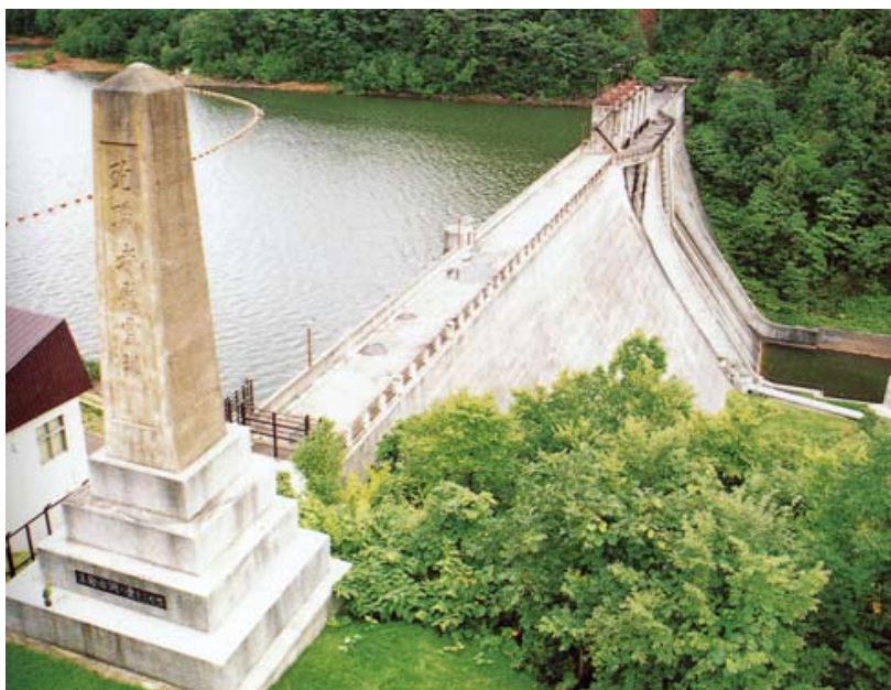
雨竜第一ダム(石狩川の碑より)
