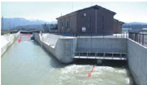
農業用水路を利用した七ヶ用水発電所 【石川県】(国土交通省北海道開発局 「農業水利施設を活用した小水力等発電 の導入促進について」より)
