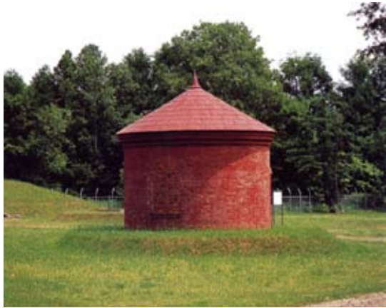
この下に覆蓋付緩速ろ過池(水道施設)がある(石狩川の碑より)
