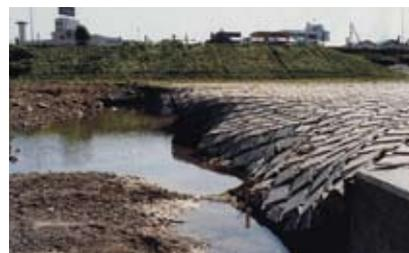
豊平川8号床止の被災状況 (札幌開発建設部蔵)
