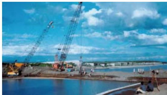
茨戸川が最高水位に達したため、完成前の「石狩放水路」を緊急通水することに。夜を徹した工事を経て翌日通水が開始されると、水位はどんどん低下して被害を低減させた（放水路水門上流側締切、撤去作業。札幌開発建設部蔵）
