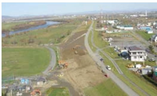
洪水の安全な流下を図る。泥炭性の軟弱地盤では、緩傾斜の堤防を整備し、堤防の安定化を図る。
