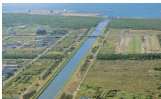
洪水を海に直接放流し、洪水時の水位の低減を図る。
