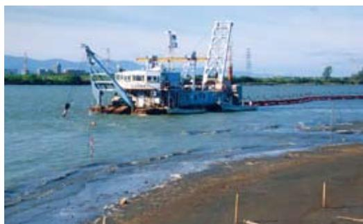
河道断面を拡幅し、河道の水位を下げるとともに内水への効果を発揮する。
