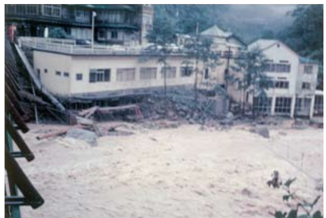
天人峡温泉での忠別川氾濫状況（昭和50年台風6号被害状況写真帳より）
