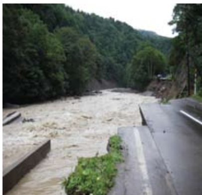
天人峡美瑛線。道路擁壁が濁流に流され道路が決壊した
