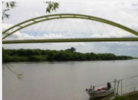
平成 23 年 3 月に開通した美浦大橋と美浦丸
