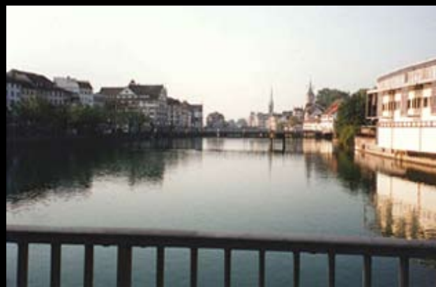
建物が川岸に接近している例（チューリヒ）
