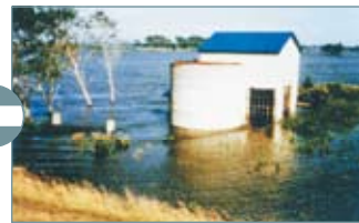
旧八幡第1排水機の湛水被害の様子
