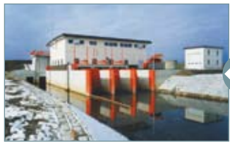
改修された八幡第1排水機の全景
