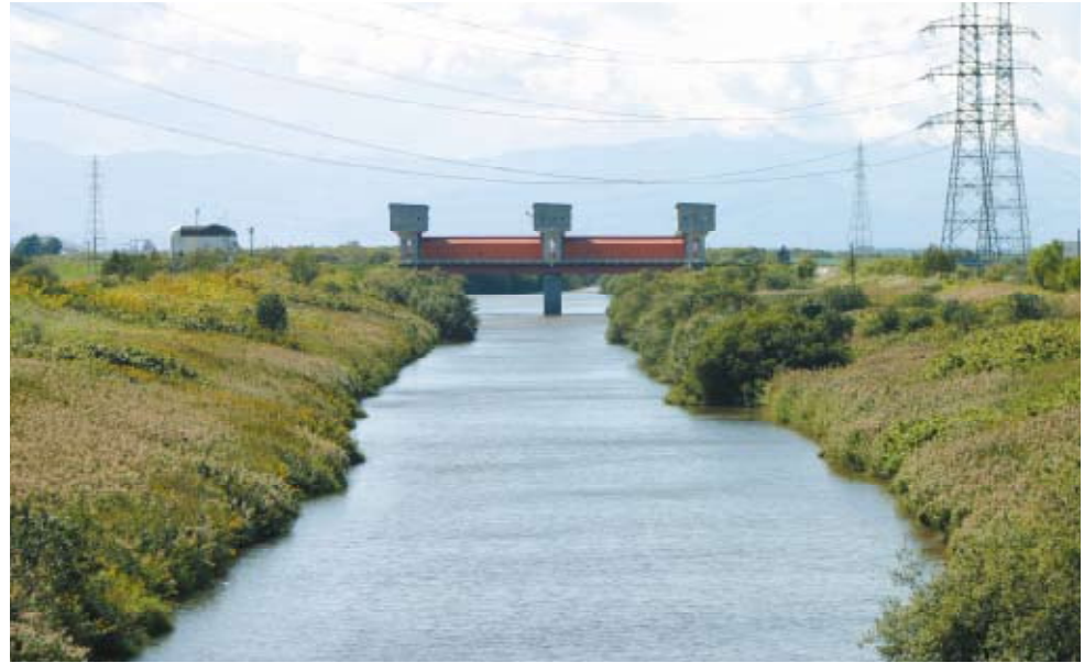
昭和56年の洪水で運河が出水し、激甚災害特別緊急事業で造られた篠津運河水門。
