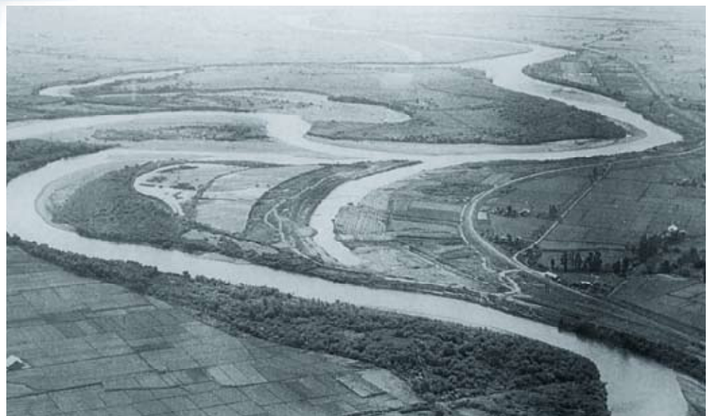
六戸島捷水路工事・滝川市(昭和35年頃。写真:「石狩川治水史」)
