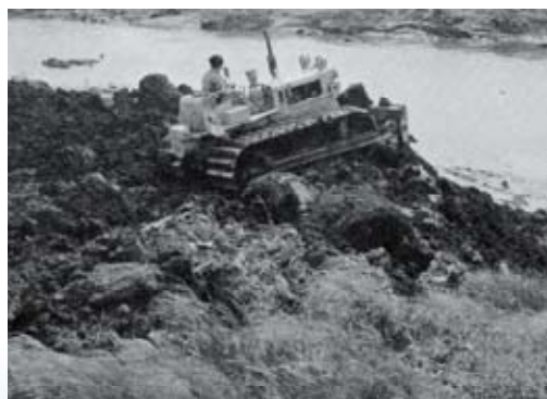
泥炭地用の湿地ブルドーザーによる整地 (「篠津地域泥炭地開発事業誌」より)
