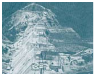
北海道初の多目的ダム、桂沢ダム (桂沢ダム写真集より)
