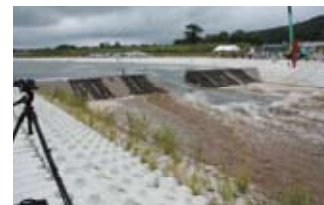
写真-5 横断堤による予備実験状況
