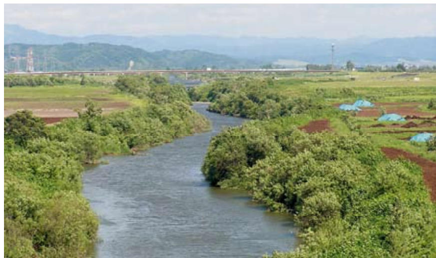
夕張川下流 栗幌橋から上流を望む
