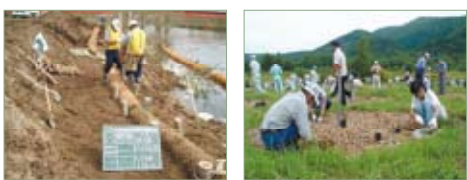
土砂流出防止工の木杭 湖岸緑化のマルチング材
