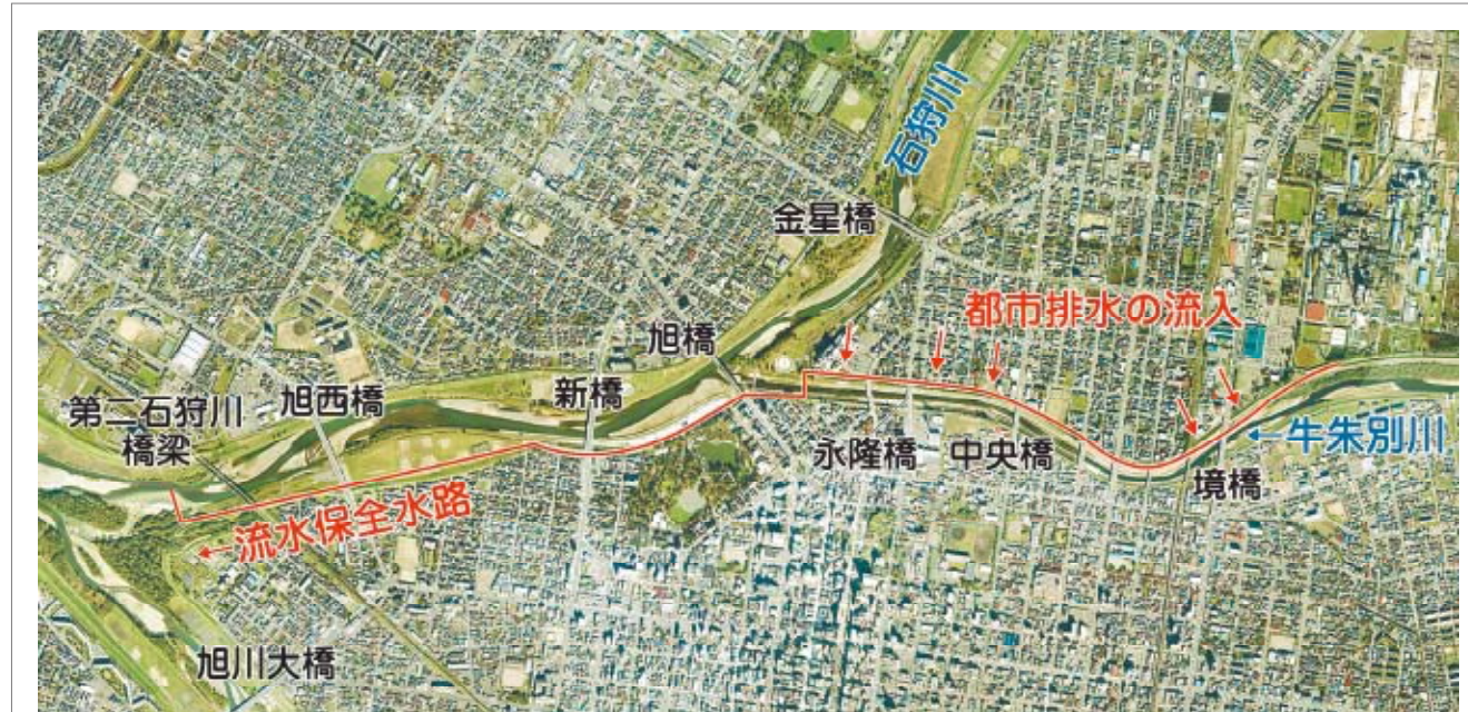
図-2 流水保全水路全景(牛朱別川境橋上流から石狩川第二石狩川橋梁まで全長約4,700m)
