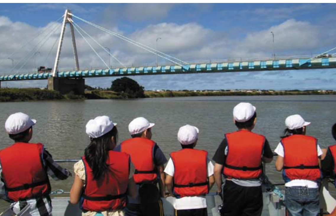
石狩川最下流に架かる北海道最長の石狩河口橋。「石狩川はデッカいなあ」
