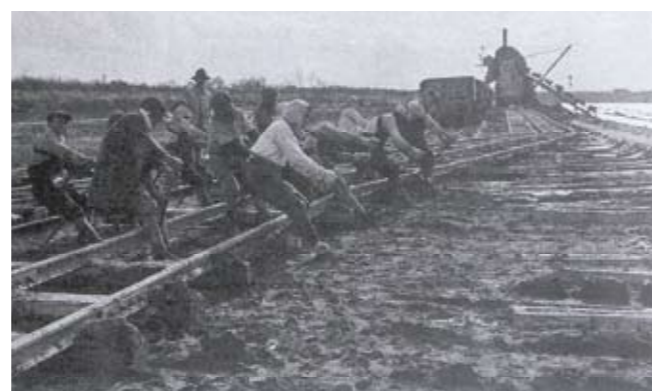
掘削機土取場線路移動作業。昭和3年頃(札幌河川事務所蔵)
