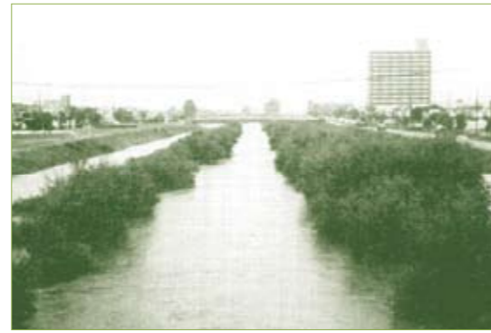
写真1 河畔林の繁茂による流下能力の低下
