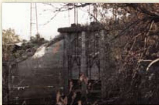
当初、自前でつくられた清真布川防水門(昭和9年築設)
