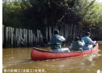
昔の杭棚工(法留工)を発見。
