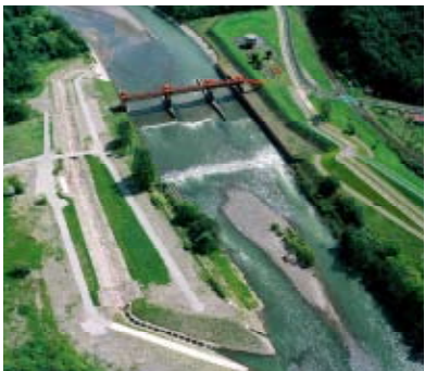
広い敷地を生かした大雪頭首工の魚道（下流から上流側を望む）。多自然型水路に階段式魚道など随所に工夫を施した。
