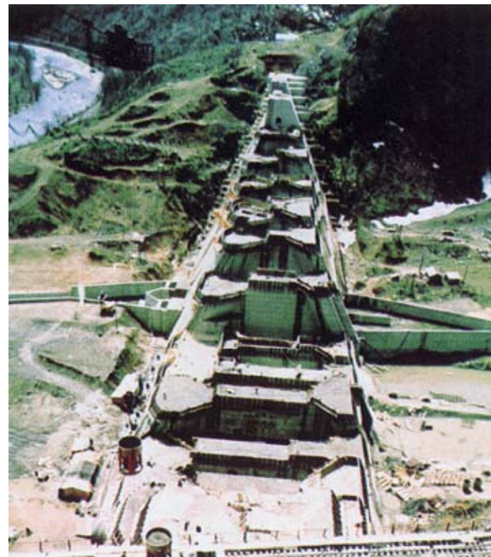
金山ダム 初の中空重力式ダム 南富良野町 昭和36年度着工～昭和42年竣工(「石狩川治水史」より)
