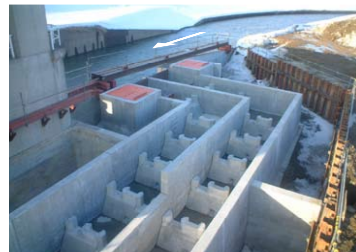
完成間近な川向頭首工魚道。左岸迂回魚道(かながい期魚道)から出口を望む。
