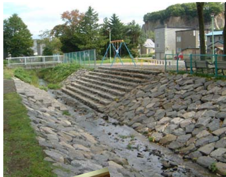
H14年度 改修区間
