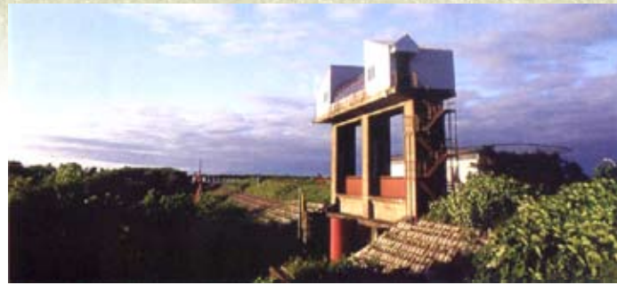
馬追運河水門と排水機場 長沼町 昭和43年竣工(石狩川振興財団蔵)
