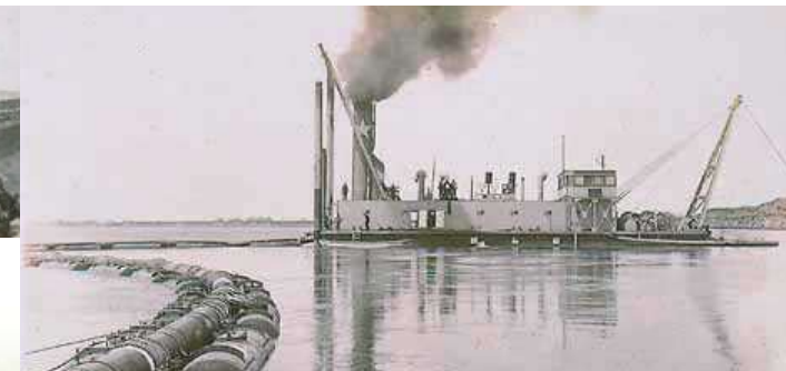
浚渫船「昭和号」(昭和2年配置・ポンプ船・浚渫能力300m³/h)(札幌河川事務所蔵)
