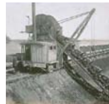
新水路掘削作業(二段掘り)(札幌河川事務所蔵)
