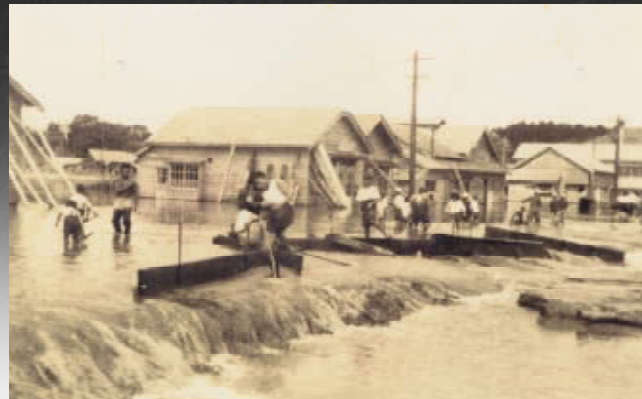
中央の様子(北広島市) 輪厚川の氾濫により道路が崩れ滝のようになっている 昭和25年8月 ●提供/北広島市教育委員会
