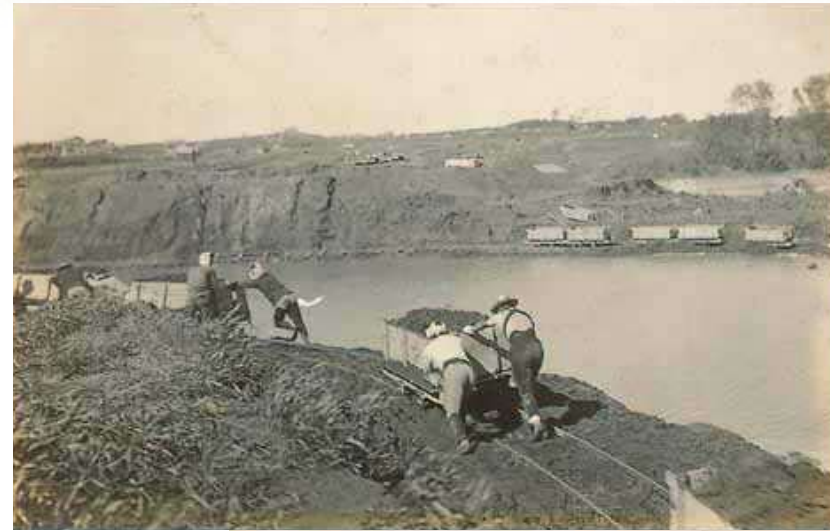
夕張川掘削(人力によるトロッコ土砂運搬)(札幌河川事務所蔵)
