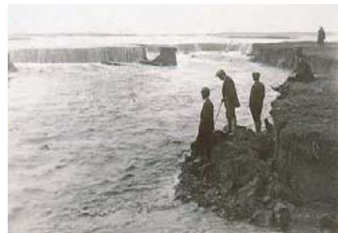
生振新水路取入口溢流による決壊状況(大正14年4月末基線左岸上流より望む)(札幌河川事務所蔵)
