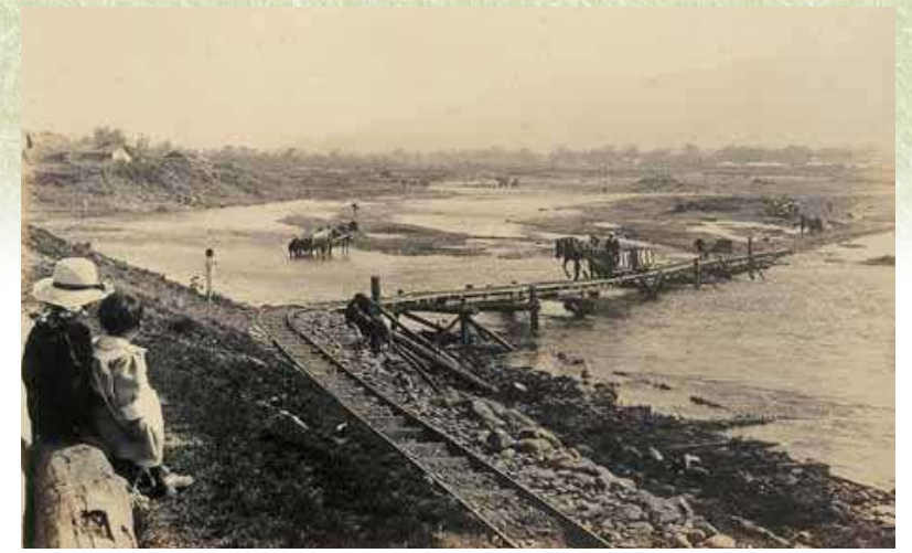
豊平橋右岸馬口による盛土運搬作業 (札幌河川事務所蔵)
