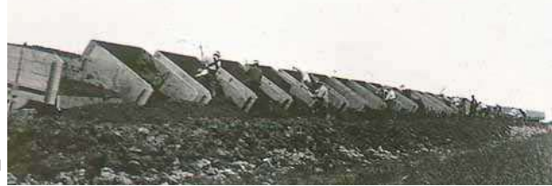
土運車による捨土作業(札幌河川事務所蔵)
