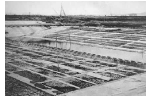
竣工した夕張川新水路床止工 昭和11年 (『石狩川本支流治水工事概要』より)
