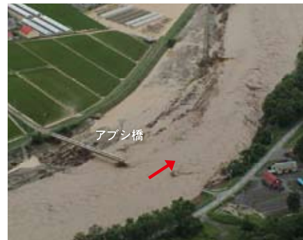
沙流川支川 網走川アブシ橋被災状況 平成15年8月10日撮影
