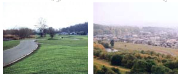
従来の概念をくつがえす、なだらかな堤防。新しく整備した忠別川の神楽側(左岸)
