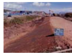
緊急復旧工事実施状況【浦幌十勝川 左岸 0.67km～0.75km】
