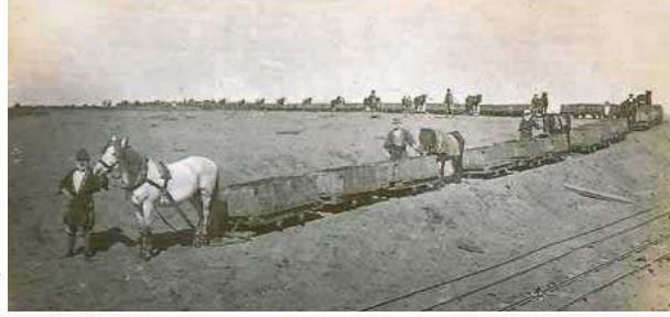
夕張川掘削(人力によるトロッコ土砂運搬)(札幌河川事務所蔵)
