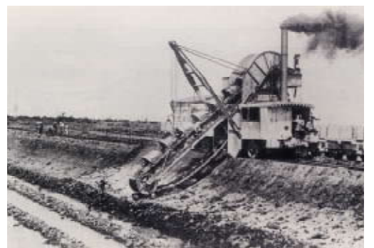
大正期の新水路掘削作業 ※掘削機械(エキスカベータ)
