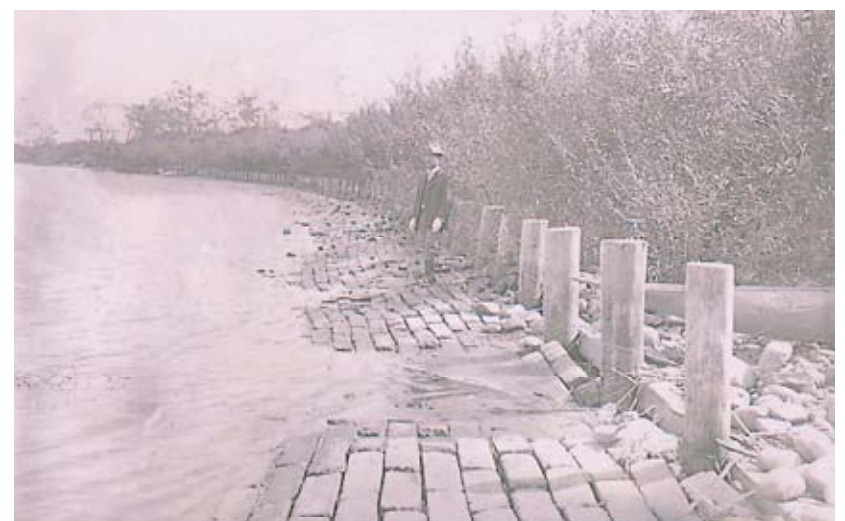
岡崎式単床ブロック護岸 大正13年頃撮影(札幌河川事務所蔵)
