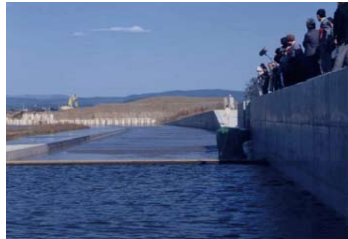
通水完了。洪水から守り、水と親しむ憩いの場として、平成15年度に完成予定。
