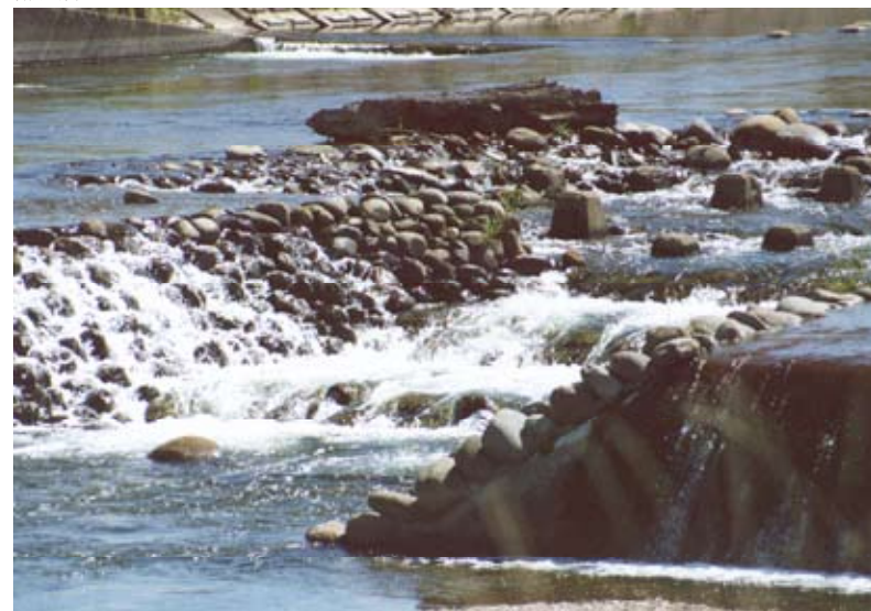
子供達も遊べるよう自然石を使った多段式の魚道。
