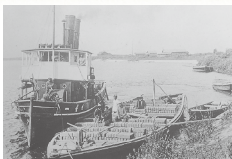
岡崎式単床ブロックの運搬(札幌河川事務所蔵)
