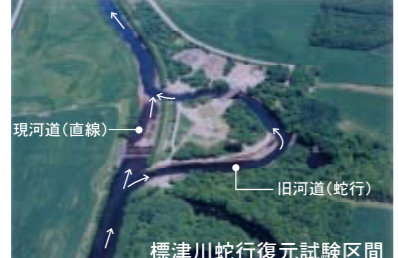
標津川蛇行復元試験区間
