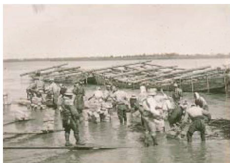
岡崎式単床ブロック布設(札幌河川事務所蔵)
