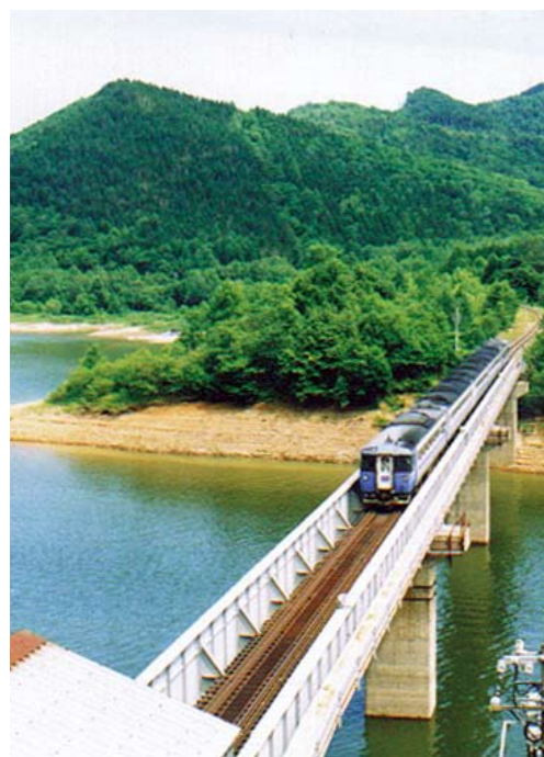
雄大な金山ダムの上を通過する、いちばんの見所。
