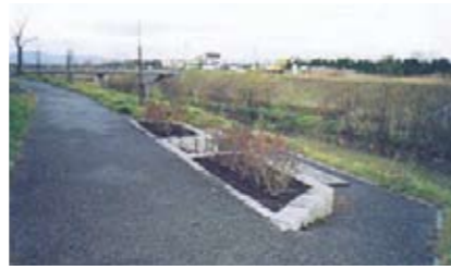
【上】散策路の完成部。舗装され桜が植樹された。【中央】雑草の植生も回復、低水路は蛇行させ河岸に変化をつけた(H11年施工箇所)。【下】河岸にはヤナギの植生回復がみられる。
