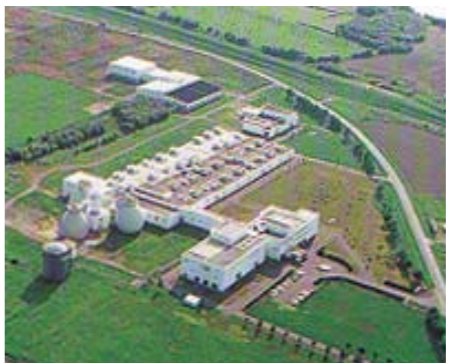
石狩川流域下水道奈井江浄化センターの処理水を再利用。その後は奈井江川・クラマナイ川に排水。
