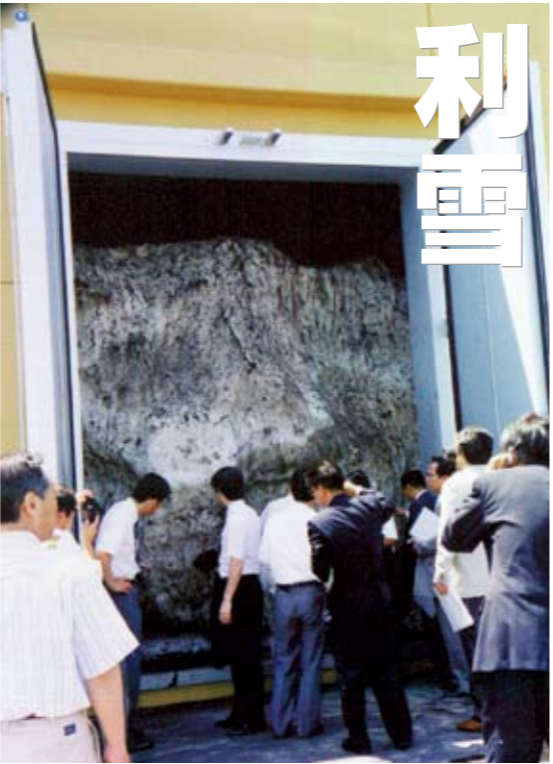
貯雪庫の雪を融かして冷水を作り、熱交換を経て各室を冷房する。
